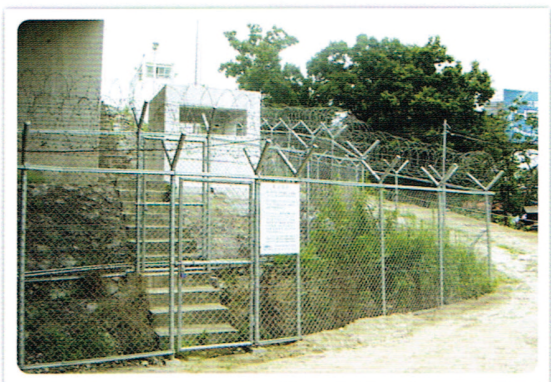
防犯フェンスの基礎
