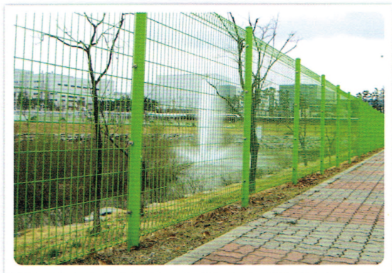
フェンスの基礎
