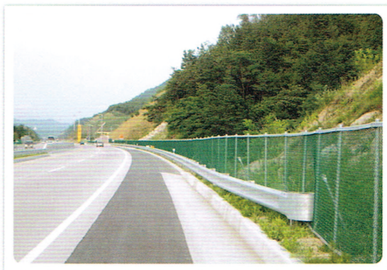
道路境界フェンスの基礎
